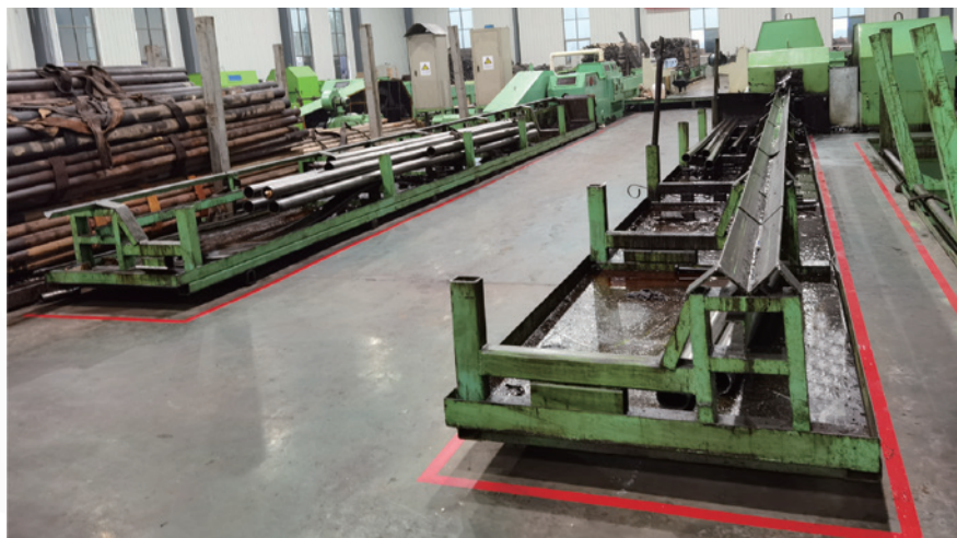
无缝钢管精轧生产线
